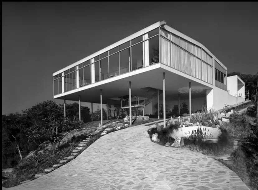
Imagem: Suspensa por pilotis de tubos de aço no alto terreno, a Casa de Vidro como era, assim que a obra foi concluída, em 1951 (Foto: Chico Albuquerque/Convênio Museu da Imagem e do Som - SP/Instituto Moreira Salles)
